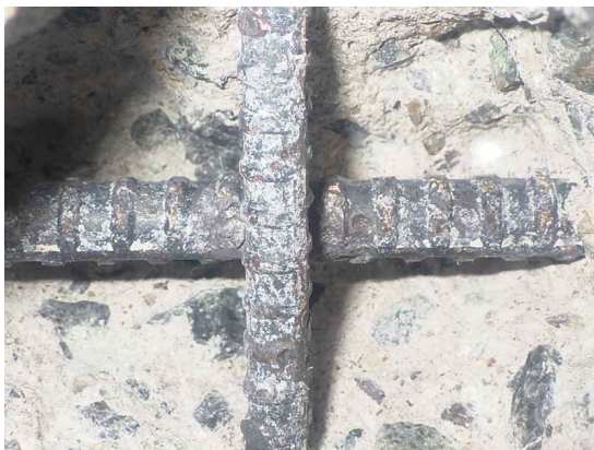
写真-4.1.11 投入前処理棟 H-K-8
