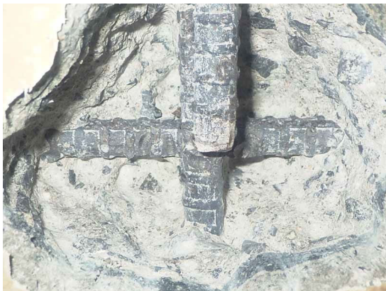
写真-4.1.3 投入前処理棟 H-K-2
