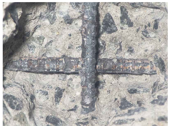
写真-4.1.10 投入前処理棟 H-K-7
