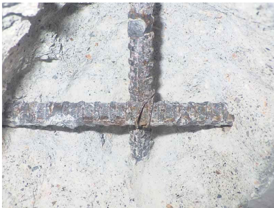
写真-4.1.15 投入前処理棟 H-K-12
