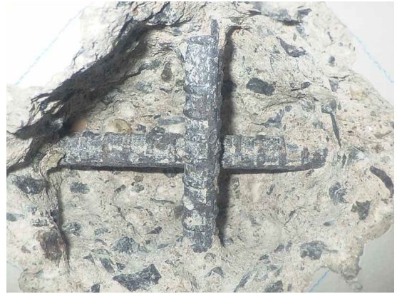
写真-4.1.8 投入前処理棟 H-K-5
