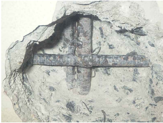
写真-4.1.13 投入前処理棟 H-K-10
