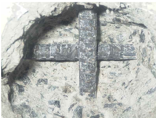
写真-4.1.5 投入前処理棟 H-K-3
