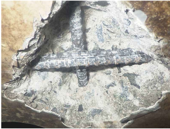
写真-4.1.19 浄化槽汚泥前処理施設 H-T-2
