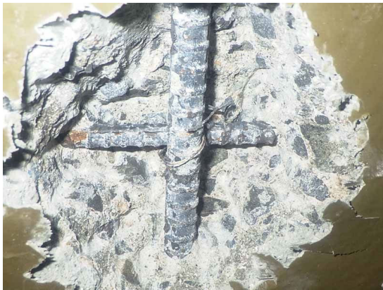
写真-4.1.17 浄化槽汚泥前処理施設 H-T-1
