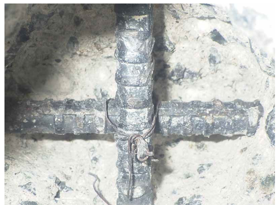
写真-4.1.12 投入前処理棟 H-K-9
