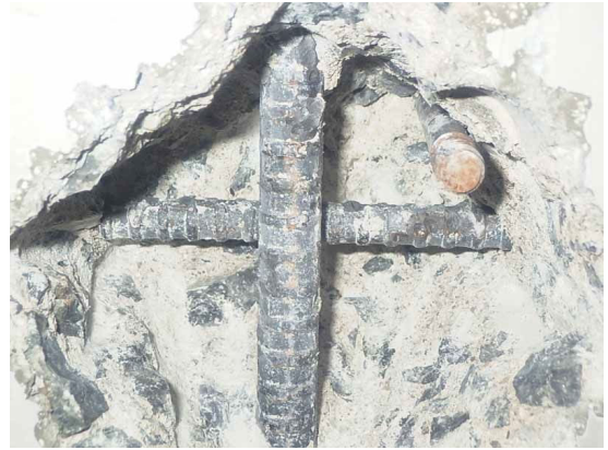
写真-4.1.14 投入前処理棟 H-K-11
