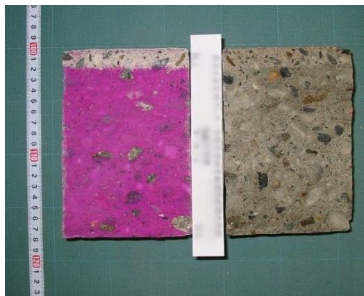
写真-3.2.4 中性化深さ測定状況(イメージ)
