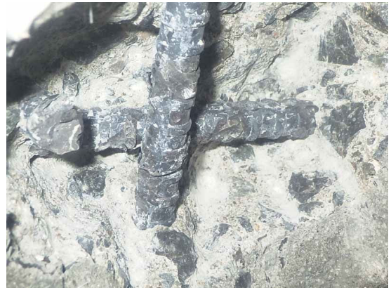
写真-4.1.2 投入前処理棟 H-T-1
